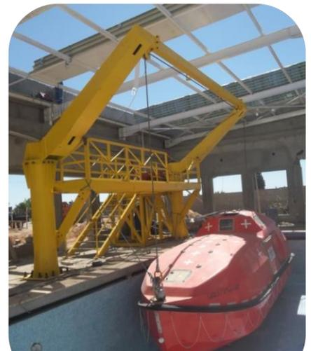
**Construction et installation d'une grue à tour et d'un palan de levage pour un canot de sauvetage 18T (2014)**
