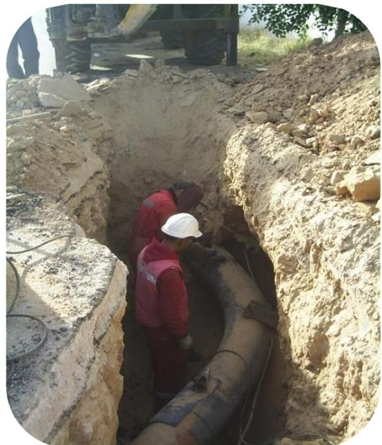
**Remplacement d'un tuyau de 8" y compris la préfabrication, l'excavation, l'installation, la soudure, l'inspection NDT et la mise en service**
