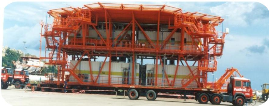
**Plateforme HELIDECK for "BARBARA H": Construction, transport, chargement et montage sur site / offshore**
