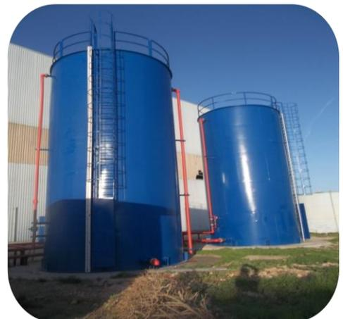
**Construction et installation de 02 réservoirs de stockage d'eau de protection contre les incendies ainsi que les tuyaux et les vannes PPR (2013)**
