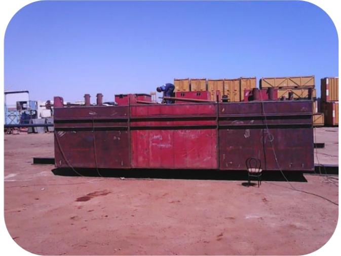
**Construction d'un Ponton Métallique Contenant 03 Caissons, longueur 12m, hauteur 2m (2009)**
